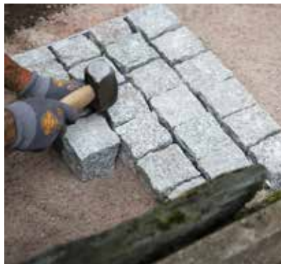
En del av gångarna i Gräsa urnlund har fått ny stenläggning av små gatstenar med jämn yta. FOTO: ÅKE JAUHIAINEN.
