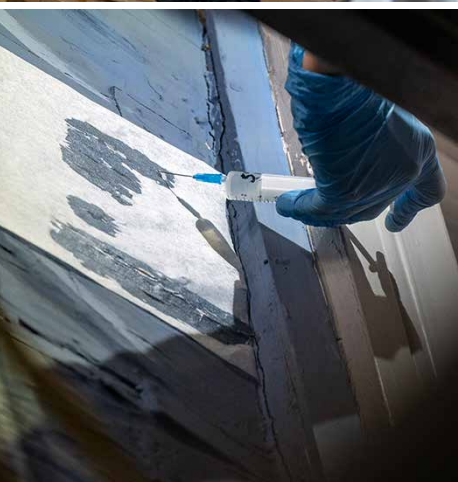
Att limma den flagade målfärgen är ett petnoga arbete.
