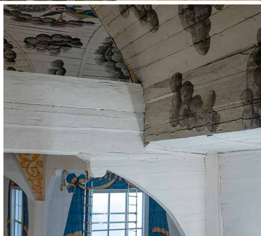
Skilnaden mellan den gamla och nya färgen syns tydligt. Takvalvet målas i ett senare skede.
