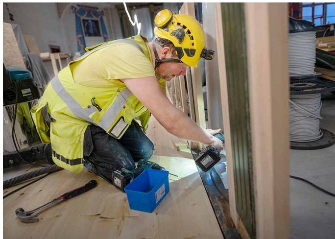
Tomas Hattar lägger nytt golv.
