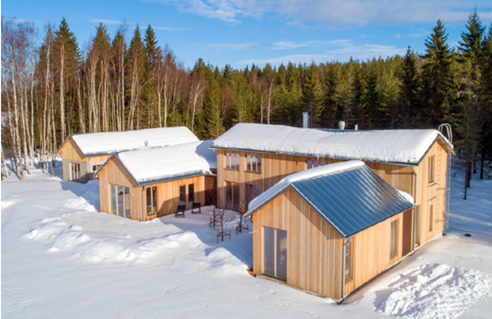
Huset Robin Nyman bygger utgående från en terrass på innergården med tre huskroppar runt den. DRÖNBILD: NICKLAS STORBJÖRK
