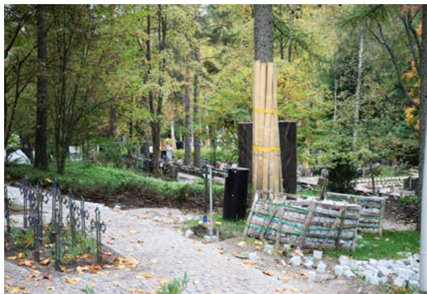
Grundförbättringen av Gräsa urnlund vid Olars kyrka torde slutföras i december 2020. FOTO: ÅKE JAUHIAINEN
