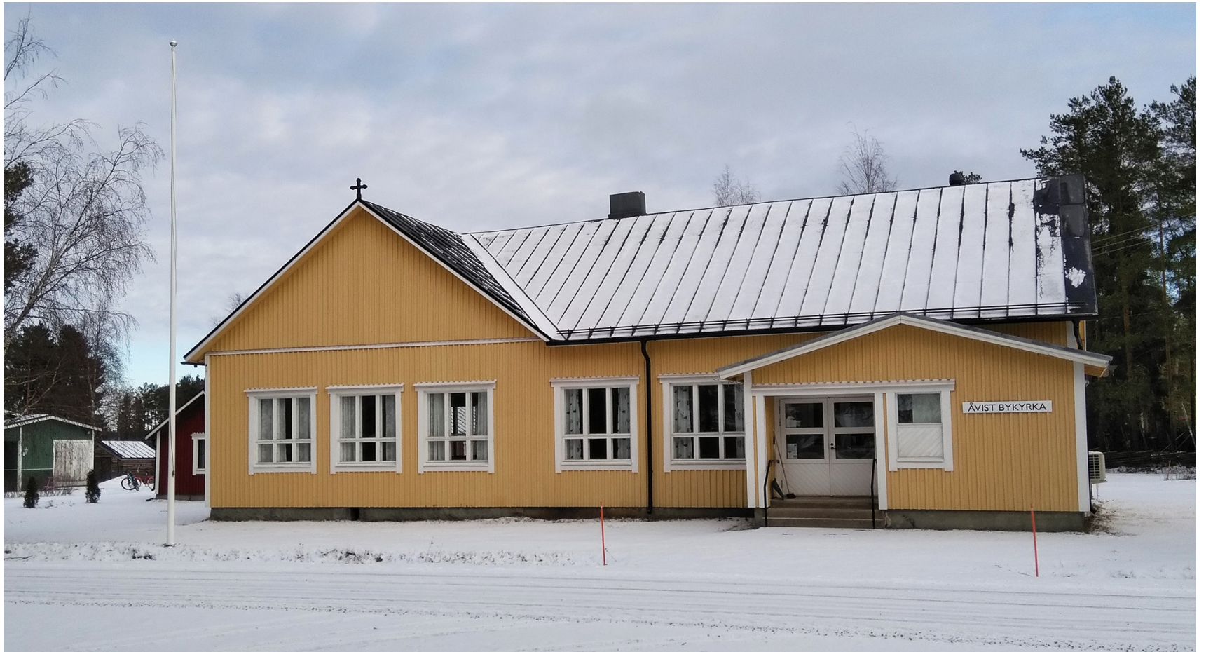
Bykyrkan, eller bönehuset som den också kallas, byggdes som skolhus på 1910-talet.
