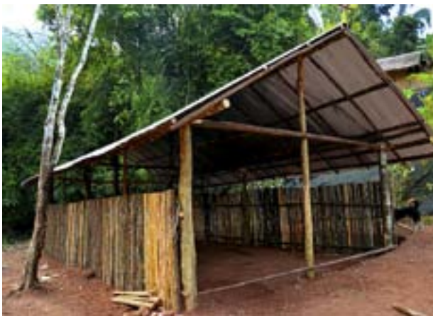
ATT BYGGA en bambukyrka är ett fysiskt krävande arbete. Volontärerna har klättrat i berg och huggit ned bambun.
