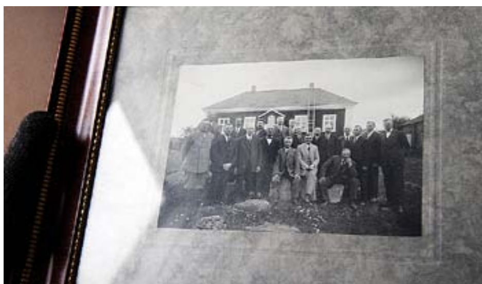
TINGSDOMAREN, TOLVMÄNNEN och övriga rättskipare har samlats på bilden som fortfarande hänger på väggen i tingshuset.
