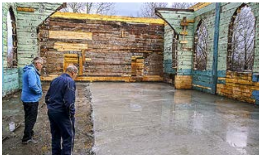
PEDERSÖREBORNA KRISTER Mård och John Östman inspekterar gjutningen av kyrkans golv. Att skrapa färg från stockarna är ett arbete som kunde göras på talko.
