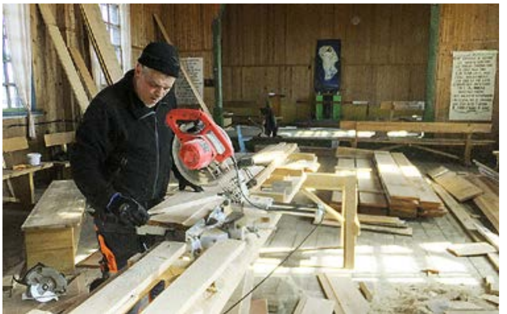
ÄVEN OM kyrksalen där Krister Mård sågar panel är en byggplats hålls här gudstjänster.
